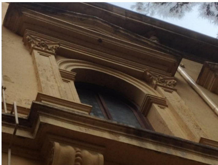
Detalle de la fachada Edificio San Pablo, Facultad de Derecho
