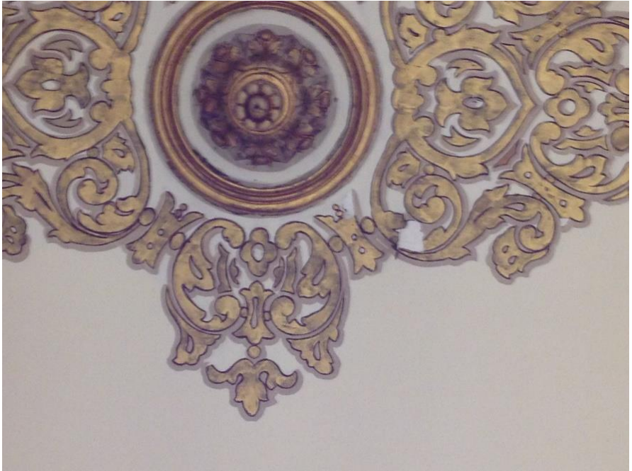
Detalle del techo. Edificio San Pablo, Facultad de Derecho
